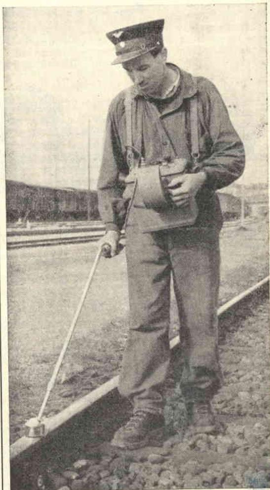
Le Ferrovie della Confederazione Elvetica hanno adottato, per il rilevamento di probabili incrinature createsi all'interno delle vecchie rotaie — dovute a sficcamento per stanchezza del metallo e non visibili esternamente — speciali dispositivi ad onde ultrasoniche.
